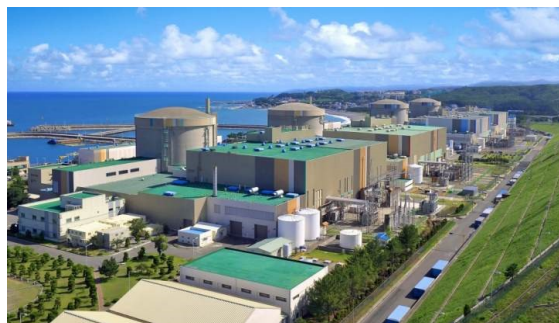
韓国 月城原子力発電所 (WNN, 17 January 2019 より)
